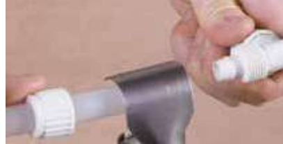
Монтаж пластиковых труб
